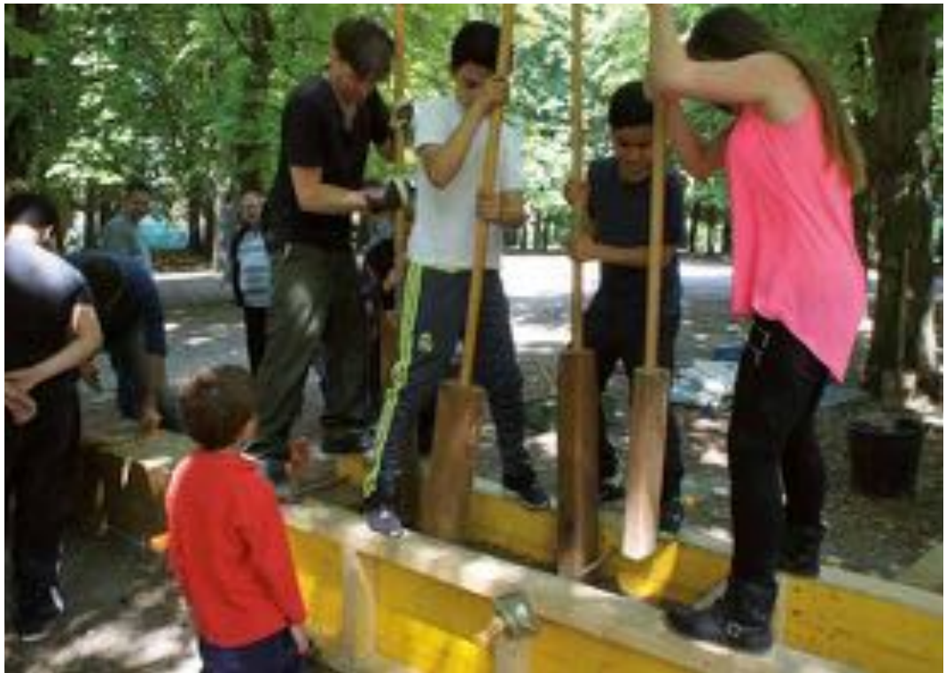
Chantier en cours avec les habitants de la cité, Bobigny, France - photo: Michèle Renard, juin 2015
